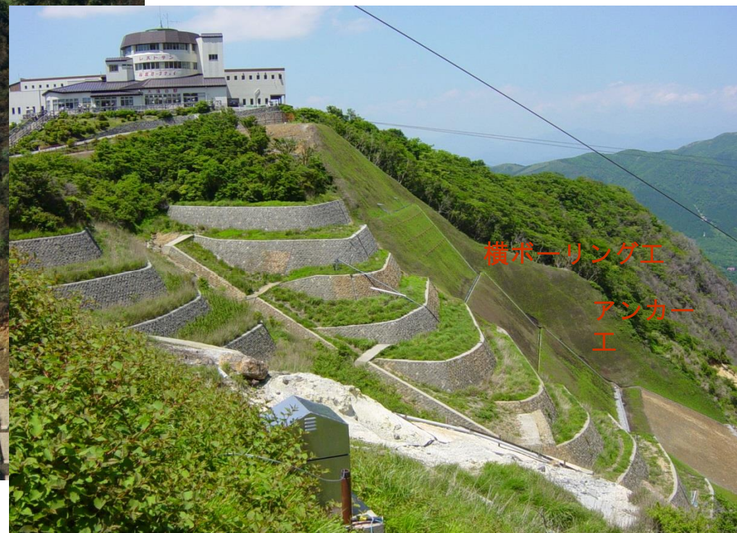
平成13年災大涌沢地すべり防止施設（神奈川県）
