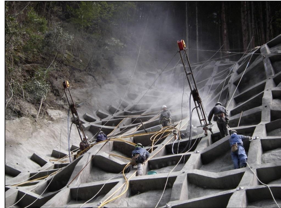
ロックボルト工
