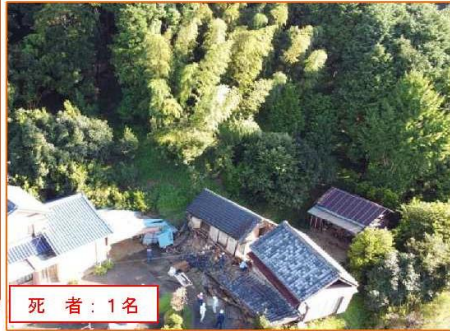
9/24 かけがわしゆけ がけ崩れ 静岡県掛川市遊家
