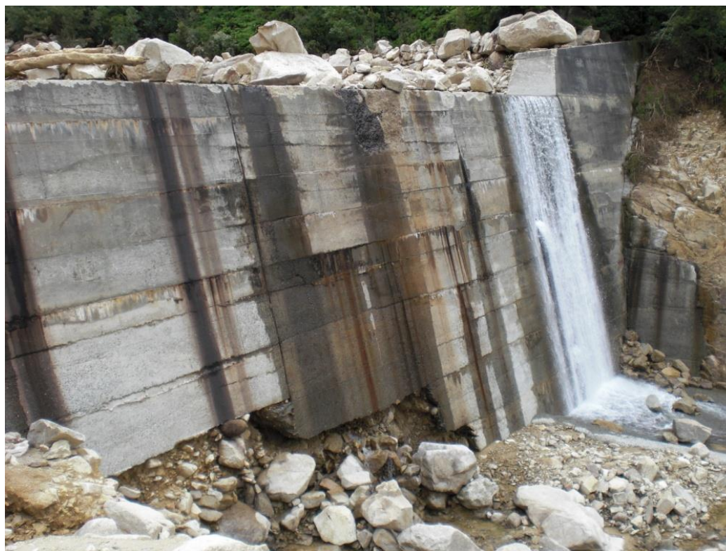
砂防堰堤被災状況（阿部谷川・山口県）
